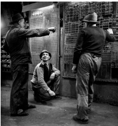
Arbeitsbesprechung am Hochofenabstich, um 1950
